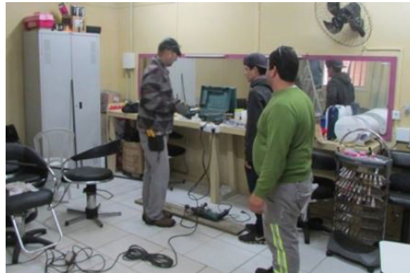
Reparos na rede elétrica
